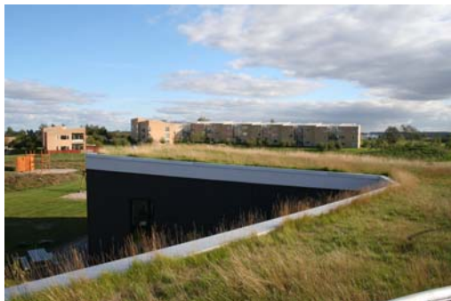
Anlægsgartner P. Malmos har brugt græsblandinger fra Prodana til taget på en børneinstitution i Bernths Have i Holbæk kommune. Udtrykket er vildt og inspireret af lignende projekter i Skotland.
