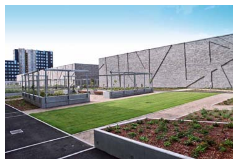
På taget af Rigsarkivet i Kbh. har P. Malmos anlagt en almindelig græsplæne med Prodanas Masterline Classic.
